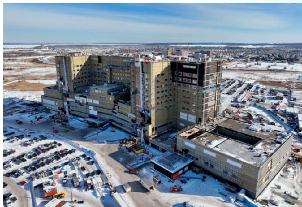
Le chantier de l'hôpital
